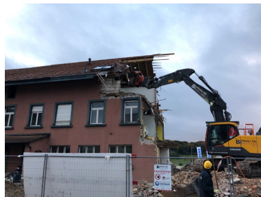
Abriss des alten Gebäudes Früeling
