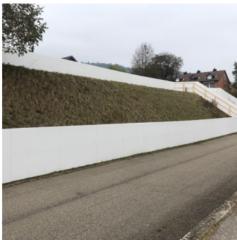
Geschützte Böschung (Orientierung Richtung Bahnhof)
